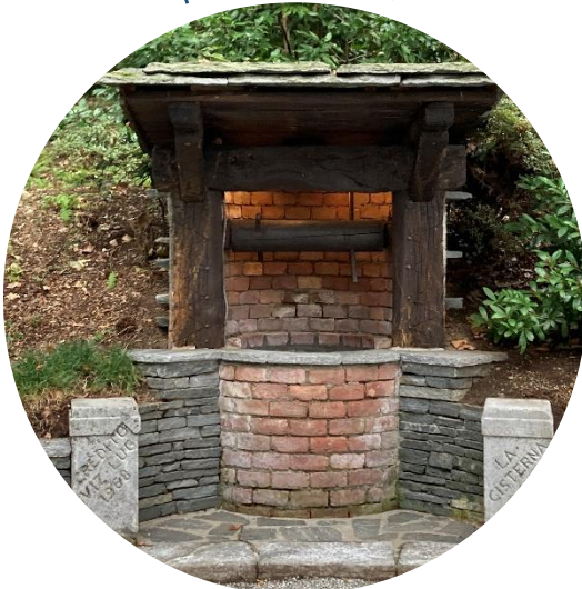
Serbatoi acqua piovana Pozzo Cisterna
